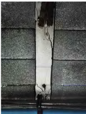
bigueta 7 fissura del formigó i visible oxidació dels elements metàl·lics de subjecció de les instal·lacions
