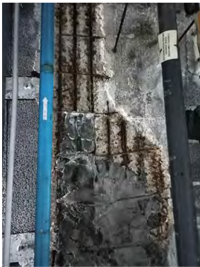
jassera a, escantell del formigó i oxidació de les armadures
