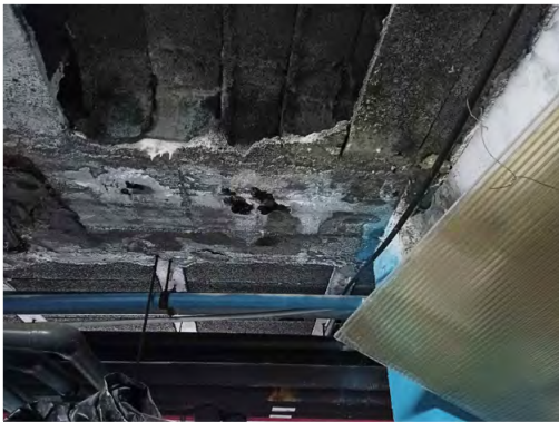
disgregació d'una sèrie de revoltons de formigó propers a la jassera a, donat l'ambient corrosiu del soterrani,
